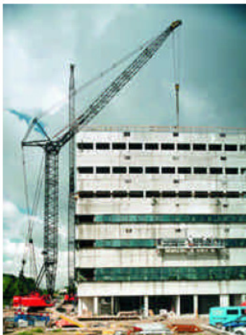
El 40% del tiempo, el operario de la grúa no tiene visión directa de la carga.
